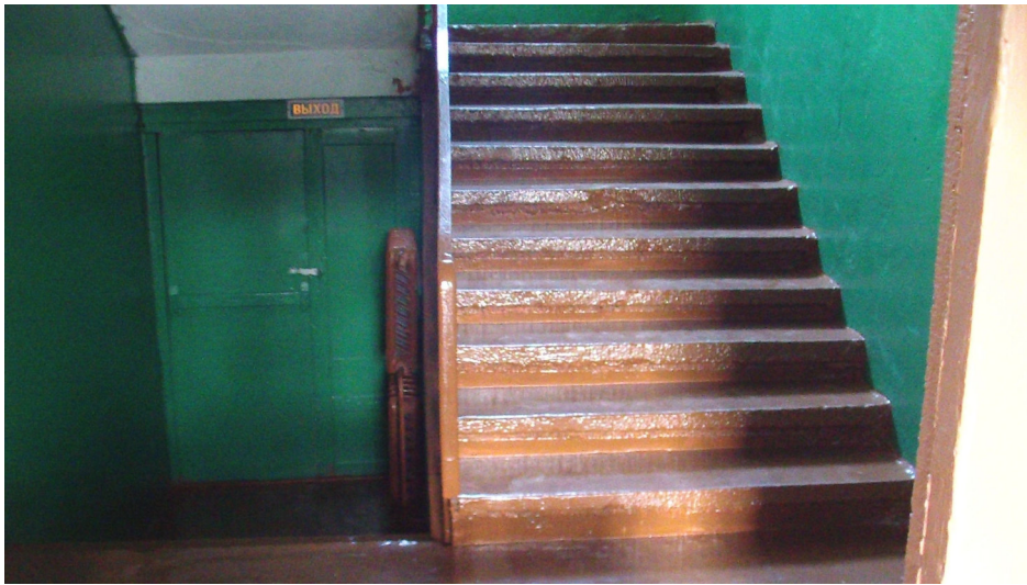
Эвакуационный выход на 1 этаже
