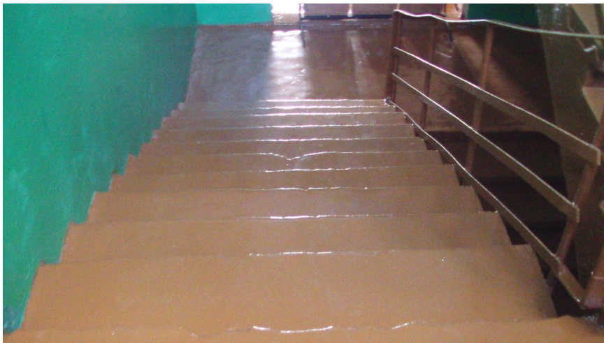
Лестница на второй этаж
