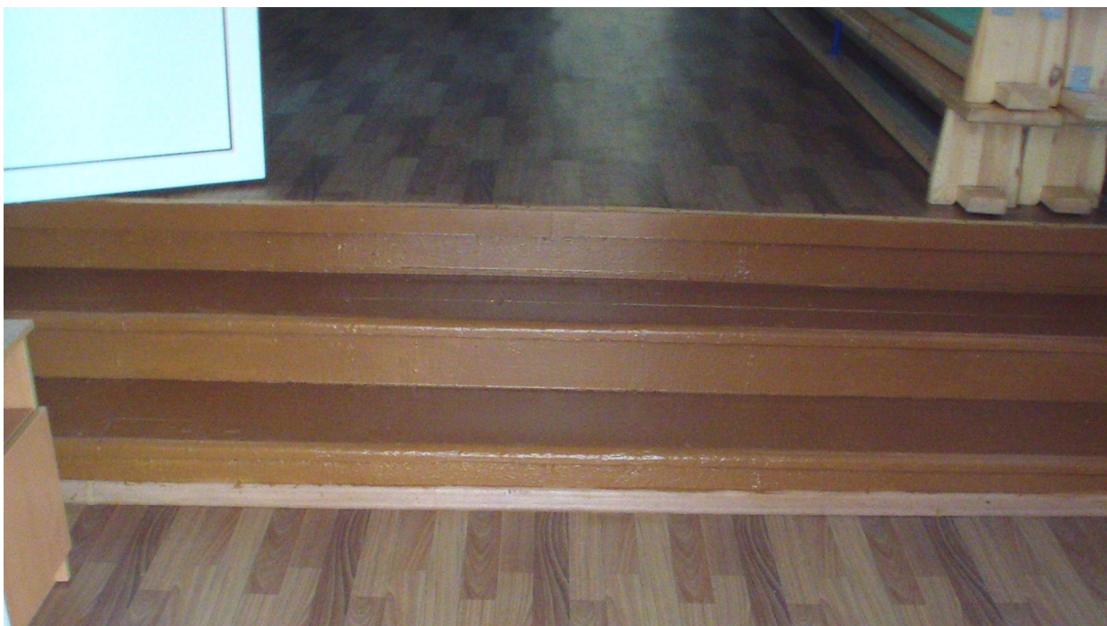
Лестница в спортзале
