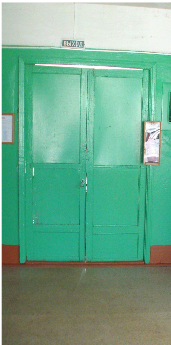
эвакуационный выход на 2 этаже
